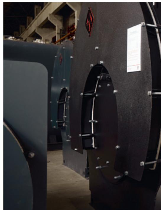
новую линейку жаротрубных трёхходовых водогрейных котлов. Первенцем серии стал котёл ДКМ номинальной мощностью 10 МВт, который предназначен для работы на газе или жидком топливе.
